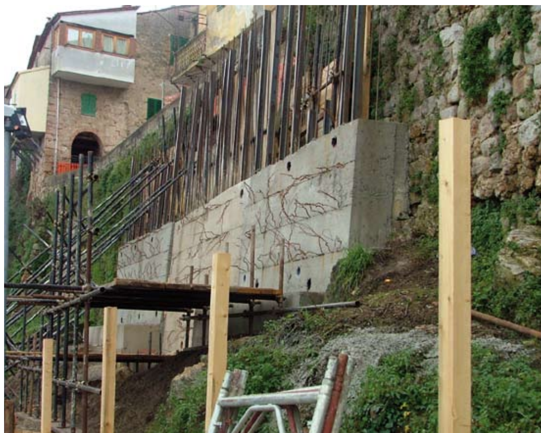
Interventi urgenti sulla frana nelle mura di San Giuliano a Gavorrano
