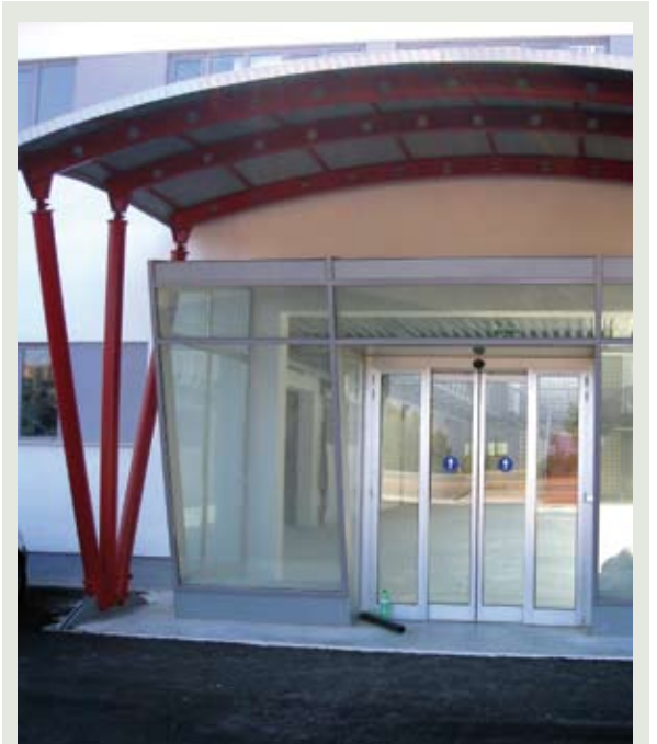
Nuova struttura di accesso all'edificio
