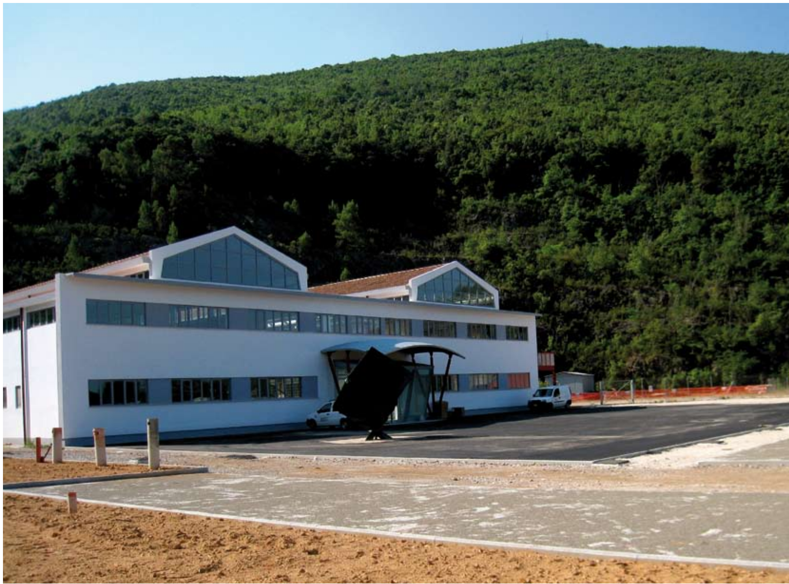
Esterno dei Bagnetti durante la fase di realizzazione dei lavori
