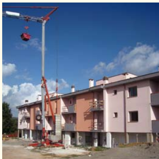
Bagno di Gavorrano, zona PEEP 167
