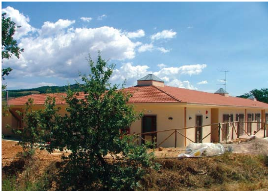
I lavori in fase di avanzamento alla "Casa Maiani"
